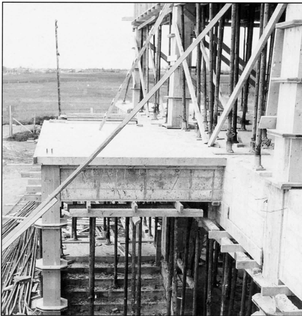
C'est cette apparence qu'avait l'entrée principale au début des travaux.
