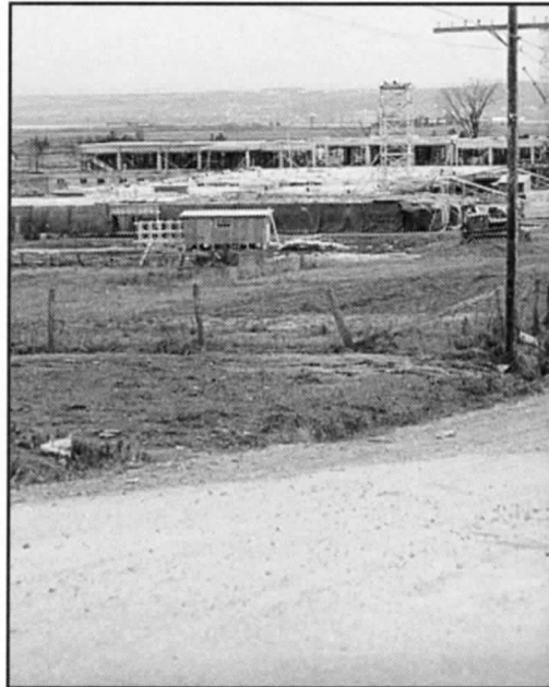
Vue vers l'Ouest du chemin BourgRoyal. C. Les travaux de construction offraient une très belle vue.
